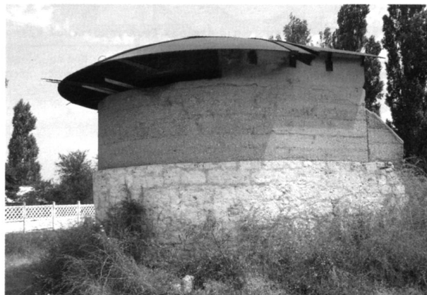
Дальномерный павильон, расположенный у левого фланга батареи № 11, сохранился в полностью первоизданном виде, уцелел даже противоосколочный козырек.
