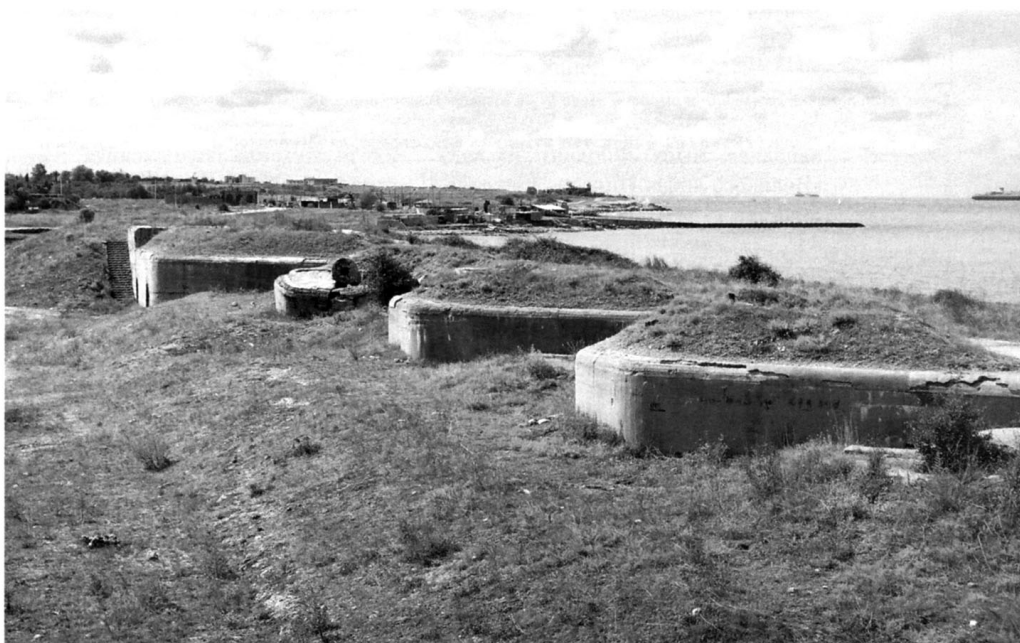
Батарея № 23 на четыре 120-мм/50 орудия, расположенная к северу от батареи № 15, предназначалась для обороны рейда и борьбы с легкими кораблями противника. Траверс между первым и вторым дворами разрушен попаданием авиабомбы.
