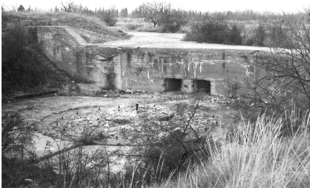
Батарея № 15 на восемь 10" (254-мм) орудий постройки 1913 г. Дворик шестого орудия: слева по траверсу поднимается на бруствер лестничный марш, у которого устроен пост наблюдателя с несохранившимся бронеклопком, правее видны два подачных окна, а в центре – остатки основания орудия.
