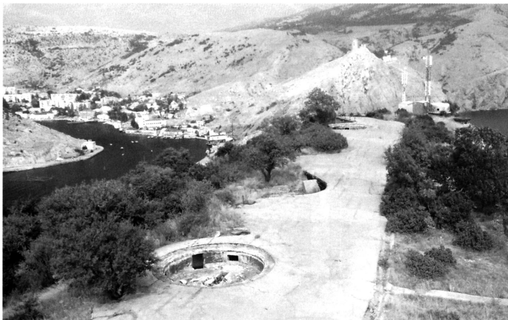
Батарея № 22 на четыре 6" пушки Канэ у входа в Балаклавскую бухту. После Великой Отечественной войны два двора на флангах батареи были перестроены в кольцевые, и в них были установлены 130-мм орудия Б-13.
