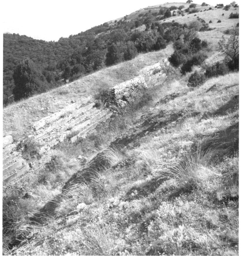
Южное укрепление. Облицованный камнем стрелковый окоп с бруствером поднимается по склону высоты. У вершины виден участок такого же окопа на правом фланге укрепления, там же расположено совмещенное с броневым наблюдательным постом убежище противотанковых орудий и два барбета.
