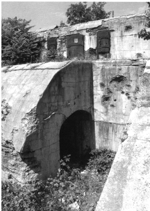
Батарея № 11. Двухъярусный траверс между третьим и четвертым двориками. В нижнем ярусе находился расходный погреб с входом, прикрытым прямым сквозником; с верхнего яруса боеприпасы доставали к орудиям прилегающих двориков.
