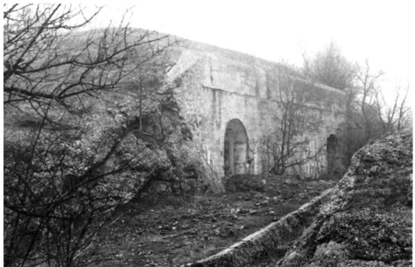
Южное укрепление. Убежище для противотурмового орудия на левом фланге. В отличие от постройки на правом фланге здесь устроен только один барбет для орудия.
