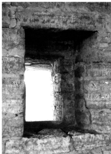
Окно боевого хода стены. Внутренний вид.
