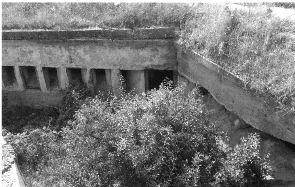
Форт литер «А». Для обороны левого флангового и левого напольного участков рва этот двойной кофр имел по десять бойниц для стрелков.
