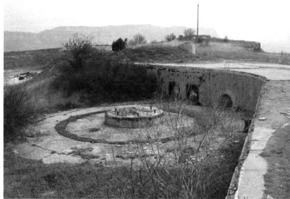
Задачей батареи № 21 дополнительного приморского фронта, расположенной на высоте Кая-Баш, было не допустить корабли противника на дистанцию, с которой можно было бы обстреливать город и порт с южного направления.
