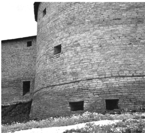
Бойницы Климентовской башни. На переднем плане две бойницы в одной печуре, фланкирующие подходы к проезду в Земляной город.
