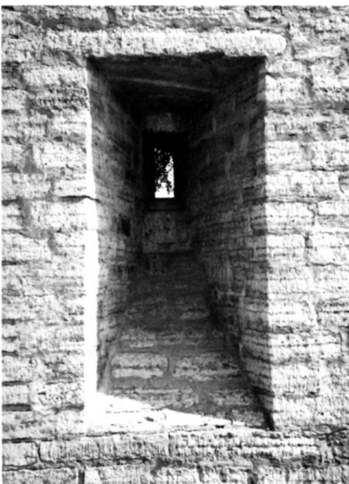
Бойница подошвенного боя около Климентовской башни. Раструб, расширяющийся в вертикальной плоскости.
