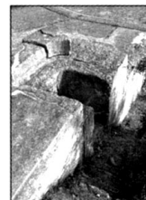
Фото на обложке – пост наблюдателя батареи № 15 Севастопольской крепости (броневой колпак демонтирован). Фото Павла Сапунова.
