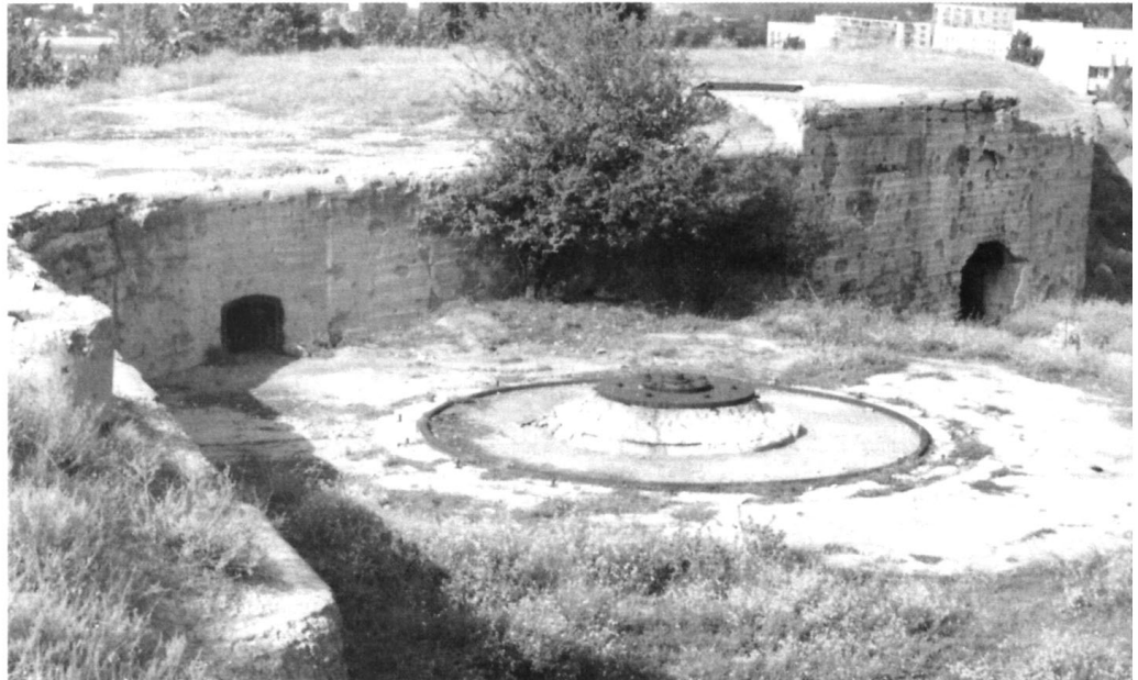
Батарея № 16 на 4 10-дм. (254-мм) орудия обр. 1895 г. Четвертый орудийный дворик на правом фланге батареи. На фотографии, сделанной в сентябре 1999 г., видно, как было устроено основание для 10-дюймового орудия. Фото автора.
