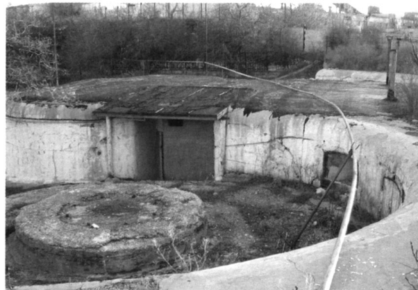
Батарея № 9 на шесть 11" (280-мм) орудий на Александровском мысе была построена в 1876-1877 гг. и позднее перестроена в долговременную. Дворики орудий прикрыты бетонным бруствером толщиной 3 м, в траверсах устроены расходные погреба и укрытия для прислуги.
