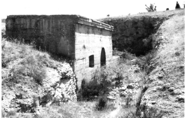
Северное укрепление. Недостроенное убежище на левом фланге. Выполненный в виде коленчатого сквозника, вход служил укрытием для противотурмовых орудий.
